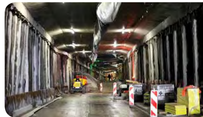
Chantier TC, Vézenaz
